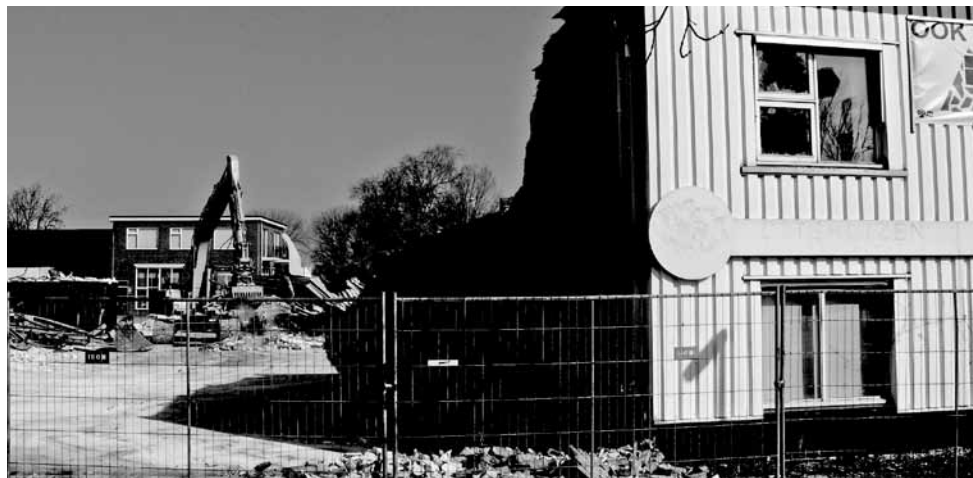
Op het bedrijventerrein bij De Hoogte gaan de eerste panden tegen de vlakte om ruimte te maken voor de ongelijkvloerse kruising.
