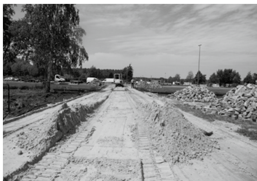
Het begin van de nieuwe toegangsweg
