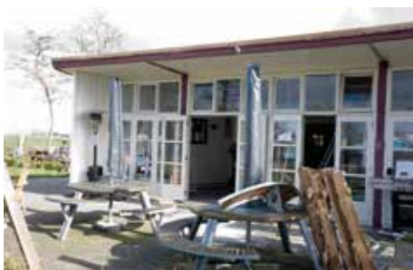
Het Paviljoen wordt opgeknapt
