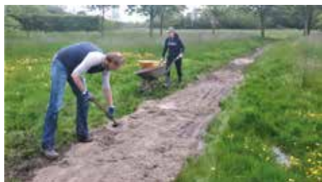
Pad in aanleg, foto: André Tervoort
