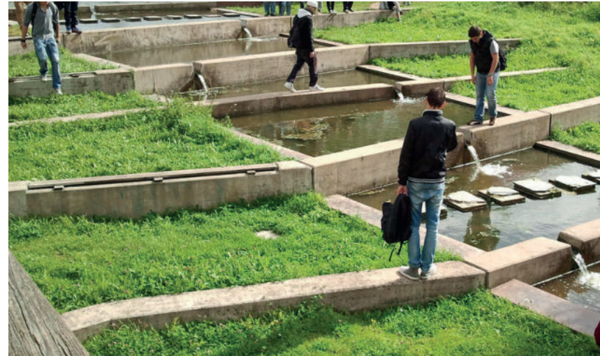
De betonnen elementen vormen zowel de trap als speelelementen in het water
