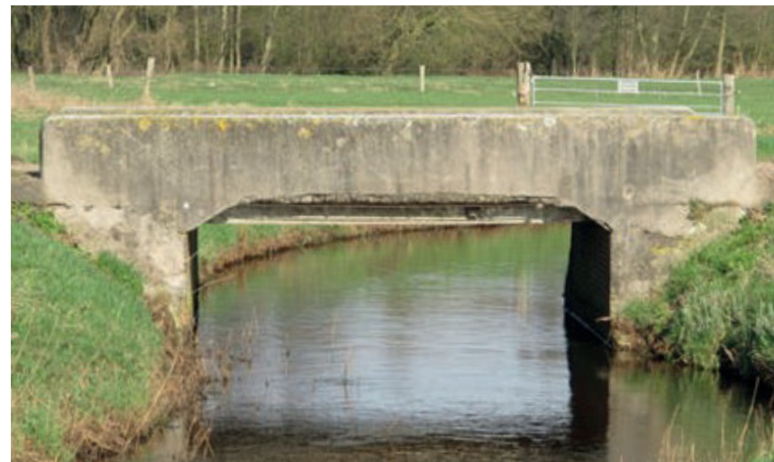
Betonnen brug zoals deze veel in het buitengebied te zien is
