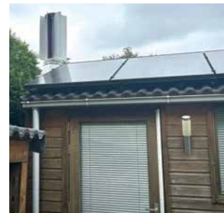
Zonnepanelen en een kleine windmolen op het tuinhuis
