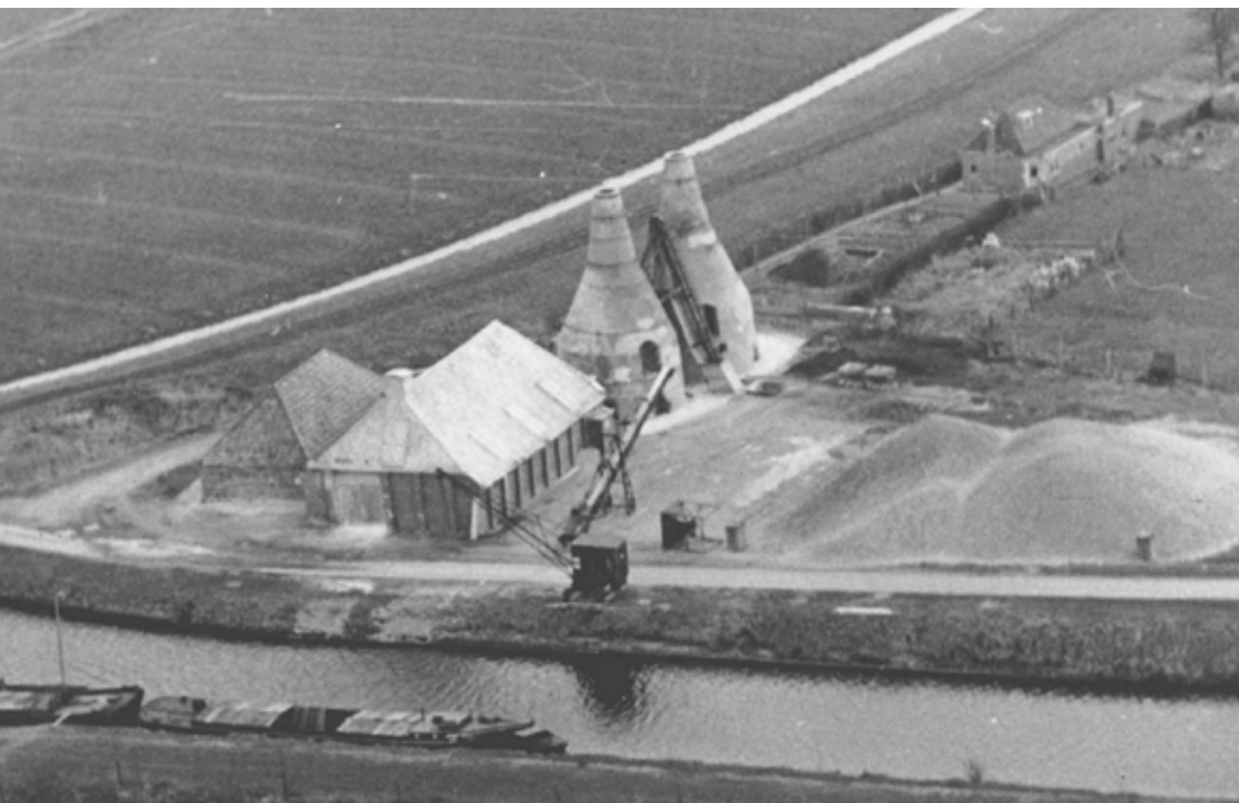
Kalkoven met daarachter het bijbehorende woonhuis.
